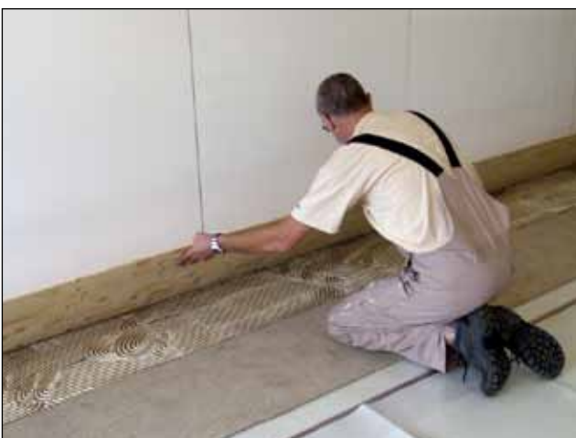
Danach wird die hochgestellte Parkettfläche heruntergeklappt...
