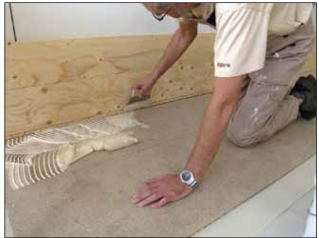
Jetzt wird mit dem Zahnpachtel für die erste Doppelreihe der Klebstoff aufgetragen.
