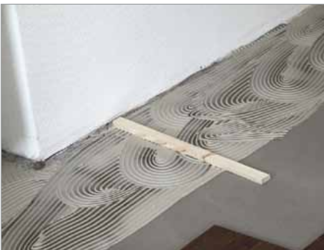
Einlegen einiger Einschubleisten.
