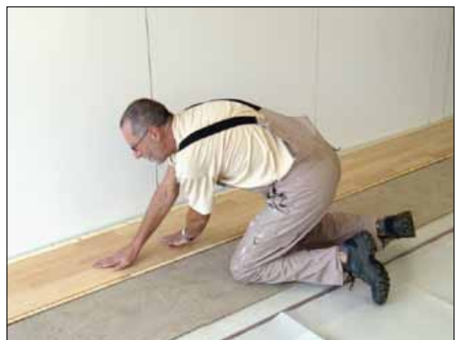
...und in das Klebstoffbett gelegt und angedrückt.
