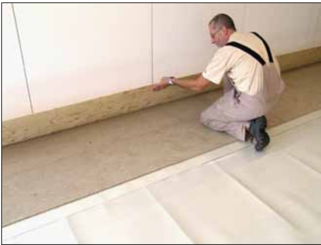
Danach wird die erste Doppelreihe an die Wand hochgestellt.
