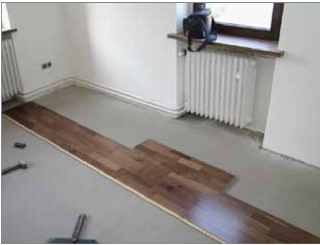
Zugeschnittene Dielen zunächst trocken einpassen.
