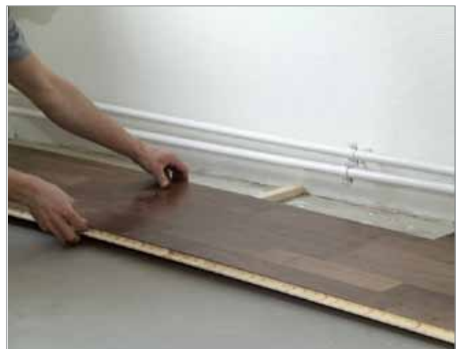
Erste Reihen auf die Einschubleisten auflegen und korrekt mit Dehnfugen zur Wand platzieren und Leisten herausziehen.
