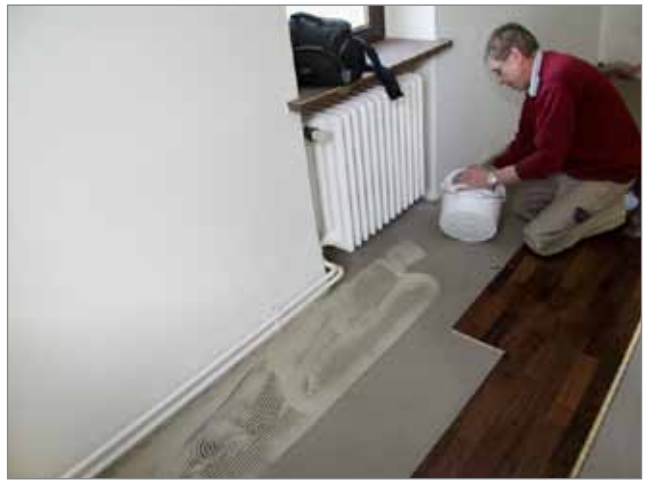
Dann bis zur Klebstoffmarkierung den Klebstoff für die ersten 3 Reihen auftragen.
